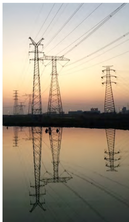
±800kV 锦屏苏南直流工程， 2011年，760kN
