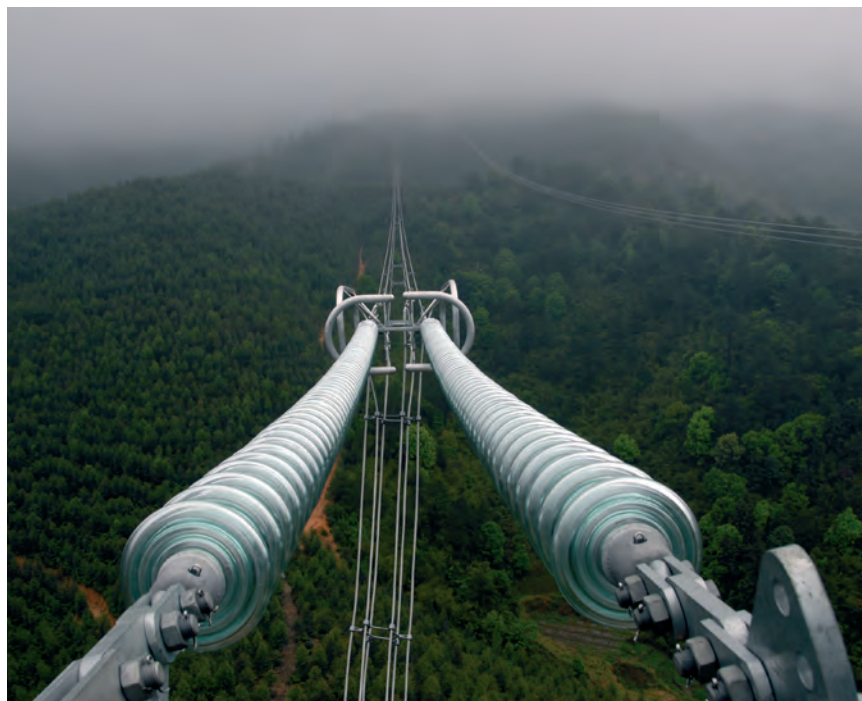
±800kV 云广直流工程，2008年，550kN 直流
