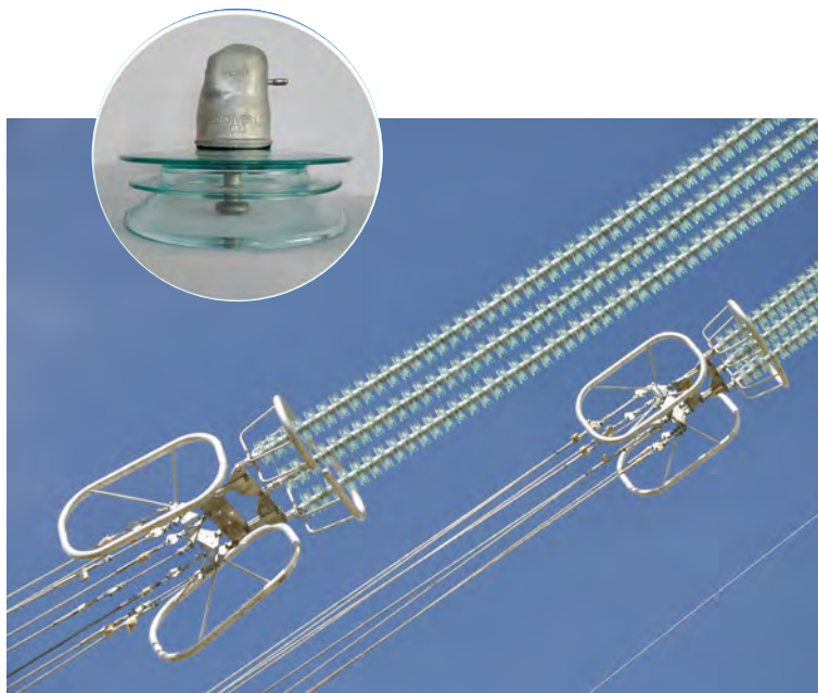
锡盟-胜利 1000kV 特高压交流工程 首次大批量使用、大吨位三伞型玻璃绝缘子
