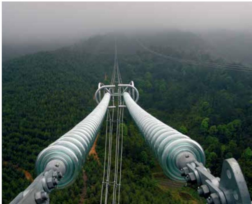
±800kV 云广直流工程, 2008年, 550kN 直流
