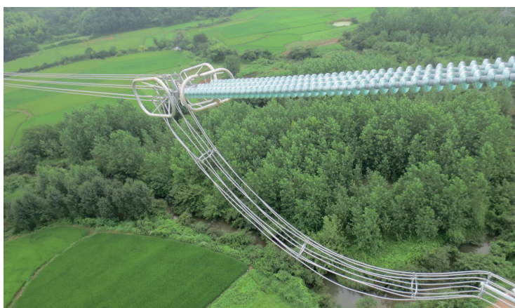
1000kV 皖电东送, 2012年, 550kN 交流
