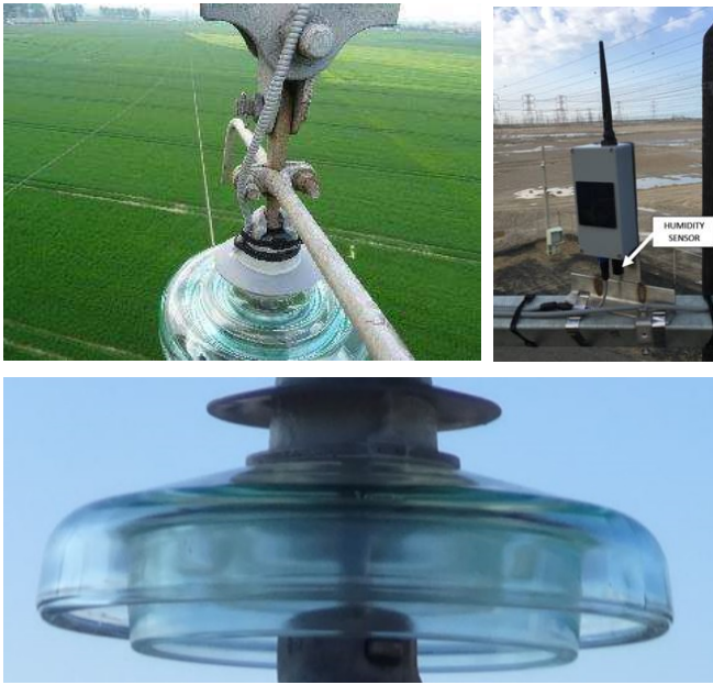
Fig. 13. Chaîne équipée sur le réseau (gauche) « end point » (centre) et isolateur connecté (droite)
